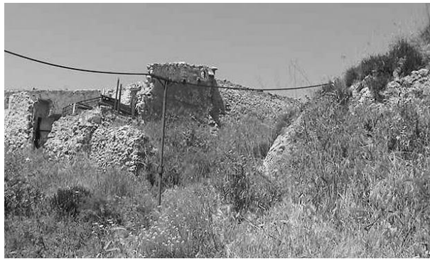
Scorcio della zona Manniri con le costruzioni per gli antichi ovili
