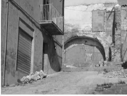
Una veduta della casa di salita Governatore dopo la sua demolizione. Si vede ancora l'arco che costituiva l'elemento caratterizzante della volta.
