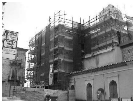
Veduta esterna della chiesa del Rosario
