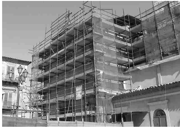
La chiesa del Rosario ingabbiata per i lavori di restauro
