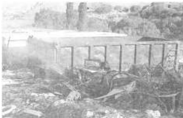
Una veduta del deposito di materiali della raccolta differenziata di contrada Vallone di Calò gravemente danneggiato dalle fiamme
