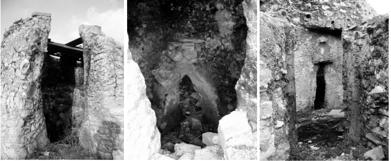
Particolari di una delle fornaci: (da sinistra) parte sommitale, interno, base.
