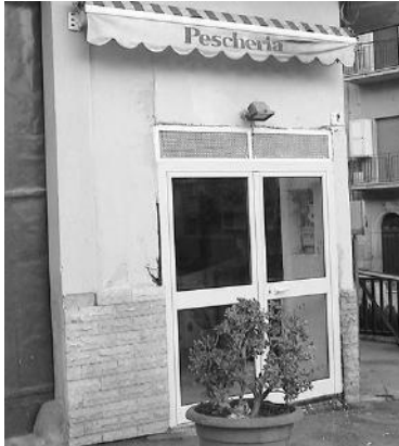
Ingresso della pescheria dopo la riparazione dei danni
