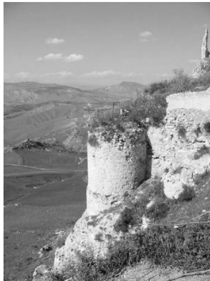
Una delle torri di estensione
