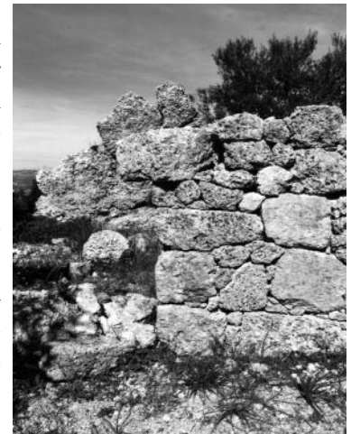
Particolare di un tratto di muro danneggiato
