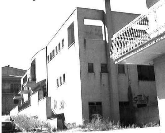
La casa per diversabili di Enna Canalicchio
