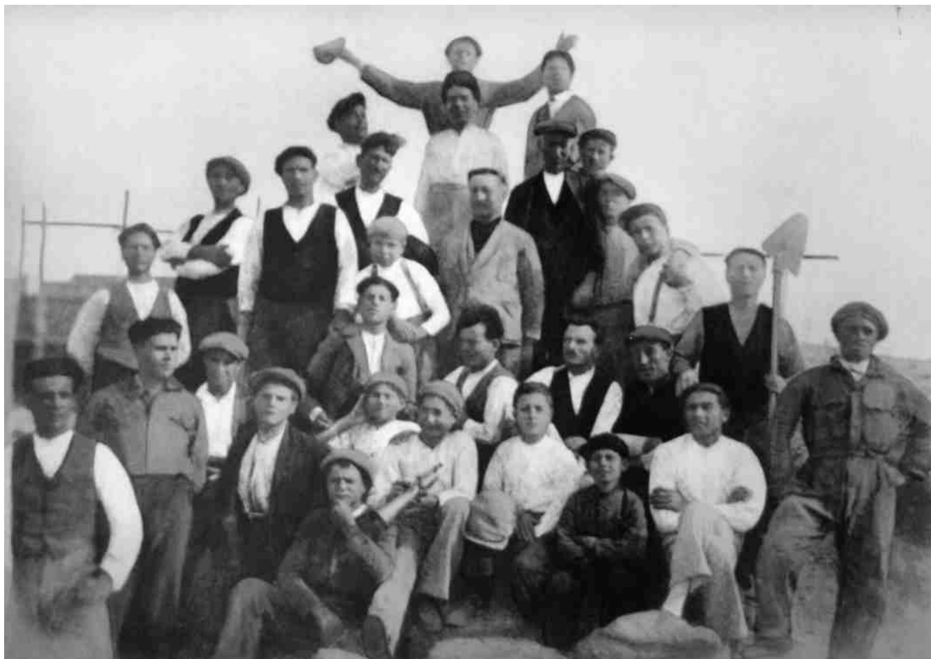
Primi lavori per la costruzione dell'edificio "Lu Statuto" sede principale dell'attuale Istituto Comprensivo "V. Guarnaccia" in Via Marconi. Nella foto tutte le maestranze partecipanti alla costruzione.
