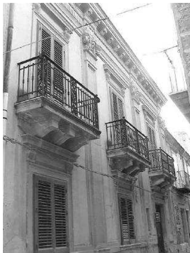
Facciata Palazzo Mendola
