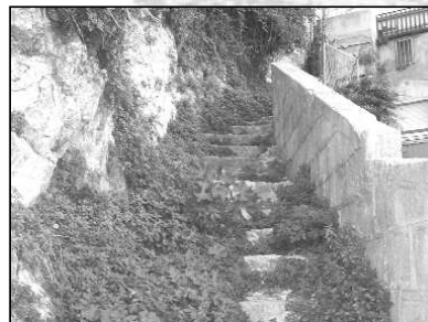
Via Vulture - muro del teatro
