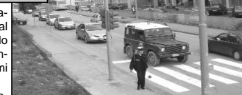
Via Unità d'Italia, sabato 21/10 ore 11,30 rifacimento segnaletica orizzontale
