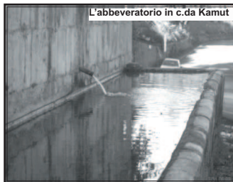
L'abbeveratoio in c.da Kamut
