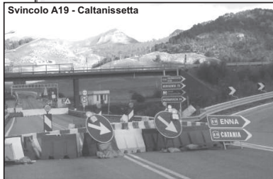
Svincolo A19 - Caltanissetta
