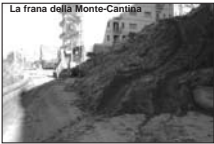
La frana della Monte-Cantina
